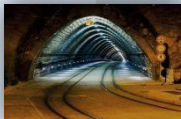
транспортные сооружения городской инфраструктуры (автомобильные и железнодорожные (трамвайные) подземные тоннели, подземные переходы и т.п.)
